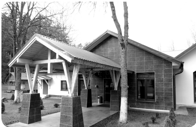
Рис. 3.2. Решение входа в ресторан «Вокруг света» в загородном клубе «Фестивальный» в Воложинском районе (Беларусь) с уровня земли без лестниц и пандусов – пример применения принципов универсального дизайна
