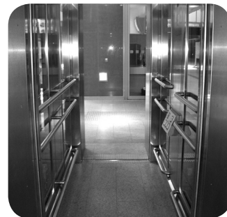
Рис. 3.5. Лифт с проходной кабиной (Германия). Горизонтальное размещение табло позволяет легко управлять лифтом людям на креслах-колясках и людям низкого роста. Цифры на кнопках продублированы выпуклым шрифтом и шрифтом Брайля
