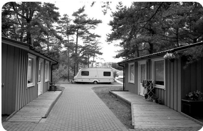
Рис. 3.3. Летние домики для размещения отдыхающих в туристическом комплексе в курортном поселке Швентойи (Литва) оборудованы пандусами для беспрепятственного подъема с уровня земли на уровень входа
